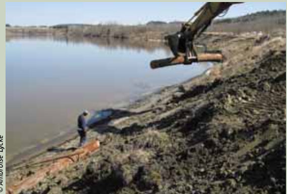
Travaux de stabilisation de rive à Saint-Édouard-de-Fabre
